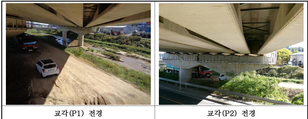
【사진 31.3.10】 교각 전경
