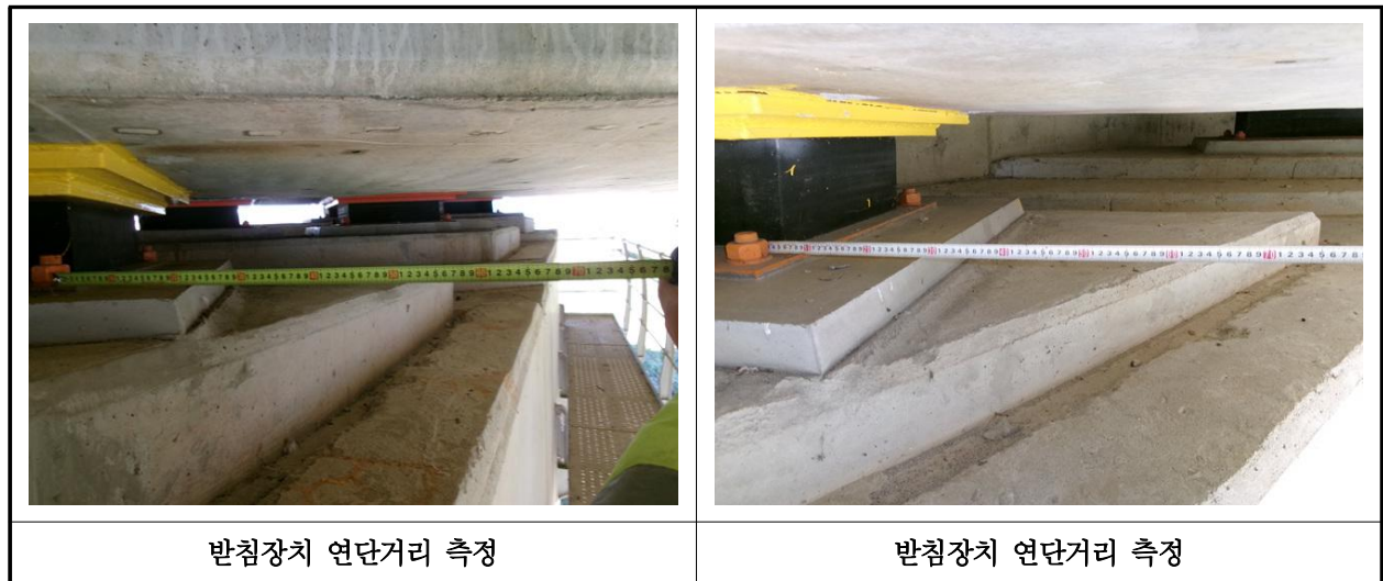
【사진 31.3.14】 교량받침장치 연단거리측정
