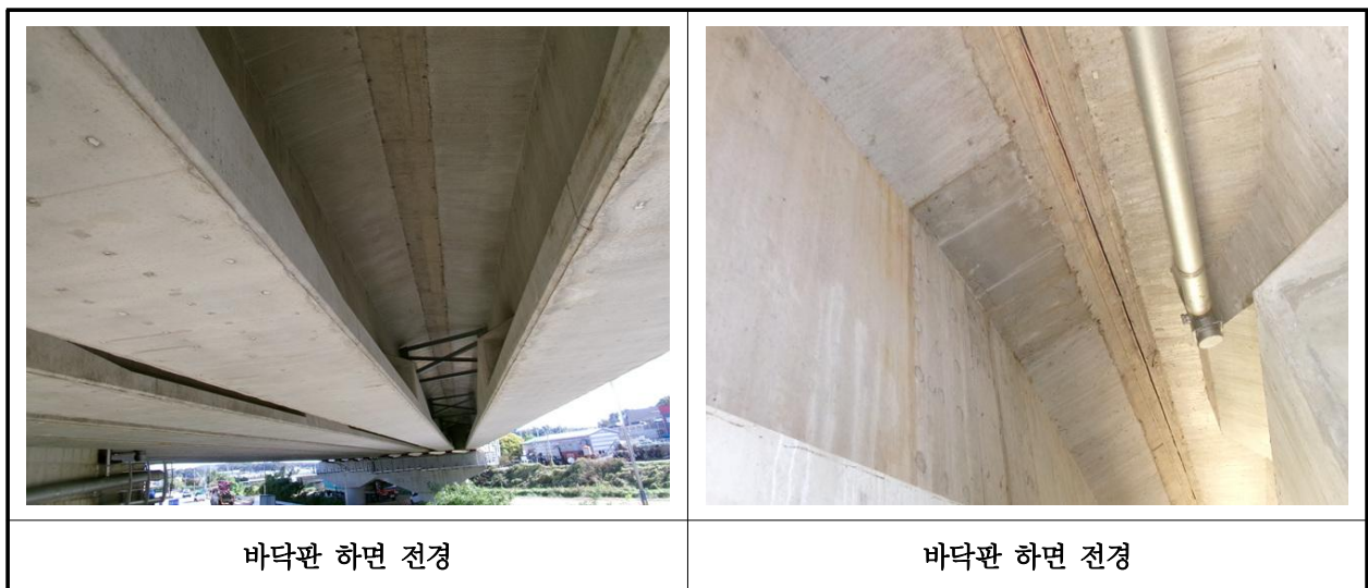
【사진 31.3.2】 바닥판하면 전경
