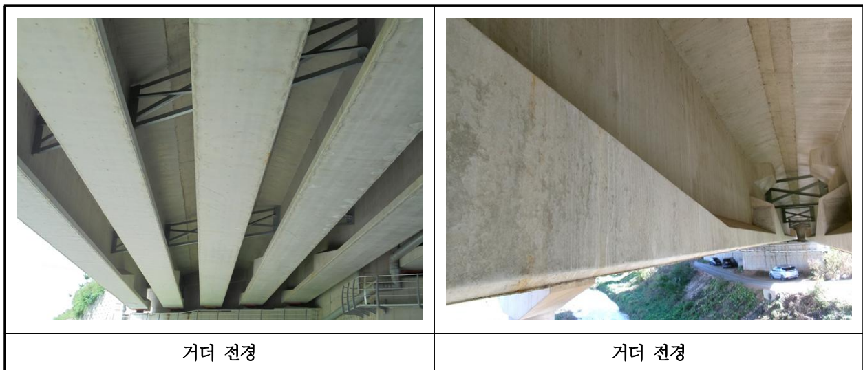
【사진 31.3.4】 거더 전경
