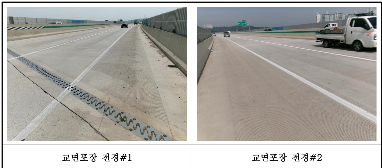
【사진 32.3.19】 교면포장 전경
