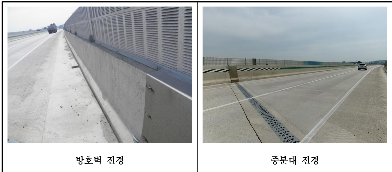
【사진 32.3.23】 방호벽 및 중앙분리대 전경
