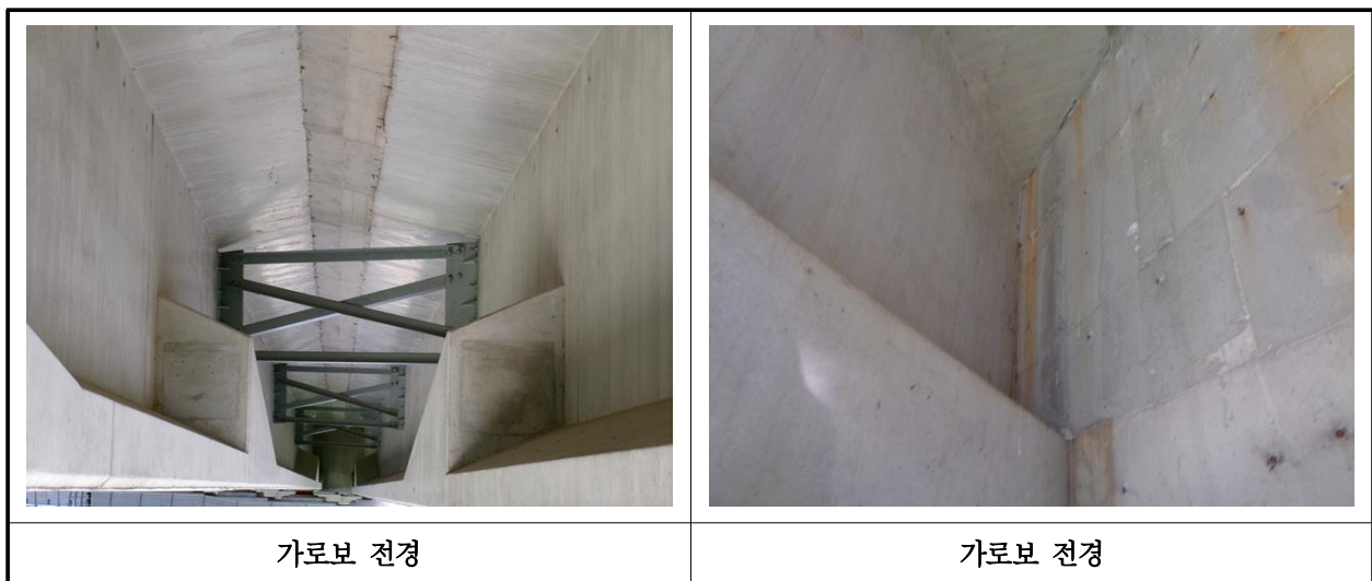
【사진 31.3.6】 가로보 전경
